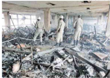
FALHA - Bombeiros no prédio sem estrutura para combater o incêndio
